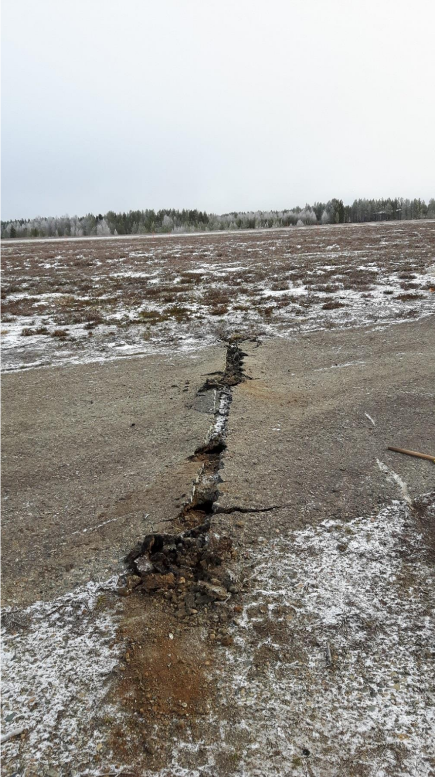
Kuva 11. Kohouma, jossa kohotettiin vanhaa raitioa KS10.
