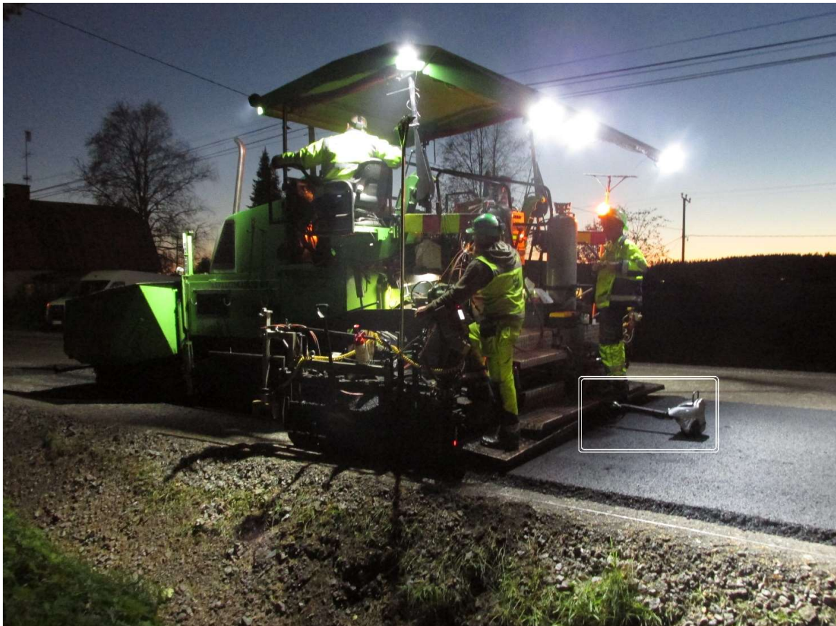
Kuva 3. Prototyyppi-pituusmittalaite asfalttilevittimen perässä.
