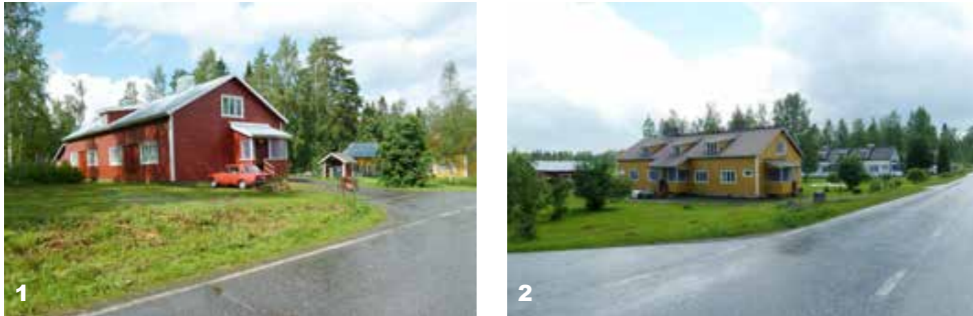
Kuva 2.29. Uusi-Värtsilän teollisuusyhteisön rakennuksien kunto on vaihtelevaa. Osa rakennuksista on kauniisti remontoituja, kun taas on erittäin huonossa kunnossa. Kuvissa 1 ja 2 näkyy alueen leimallisin rakennustyyppi. Kuvassa 3 on Yhteishyvän rakennus, joka sijoittuu lähelle yleissuunnitelman linjauksia.
