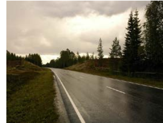
Kuva 55. Valtatie leikkaa Rouanahon dyynimuodostumaa useassa kohdassa. Dyyniharjanteiden puusto on monin paikoin avohakattu.
