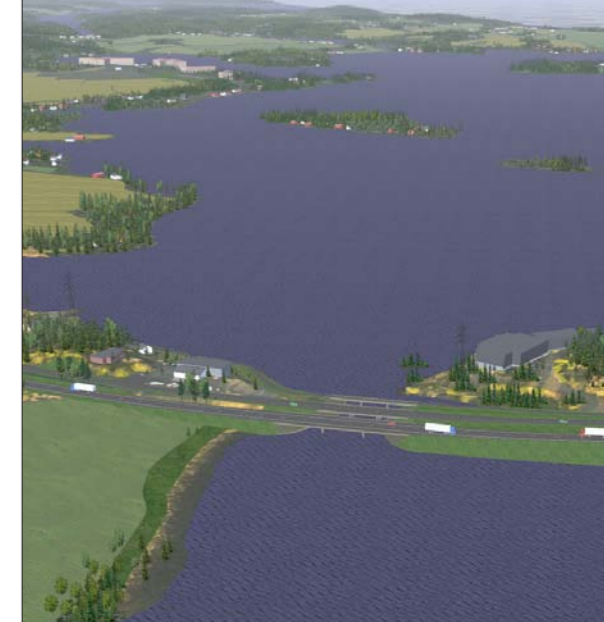
Salmin kohdalla valtatie rakennetaan uuteen paikkaan.
