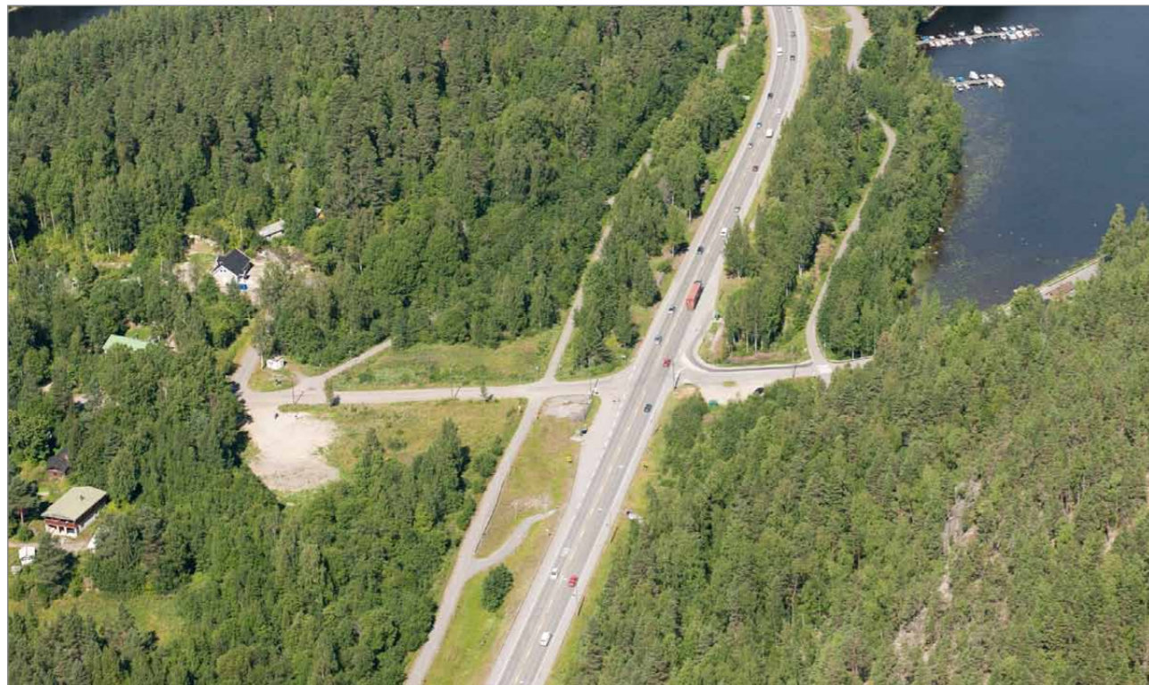
Kuva 12. Hupelintien liittymä vasemmalle ja Etu-Kanavuorentien liittymä oikealle valtatiestä. (Lentokuva Vallas Oy.)
