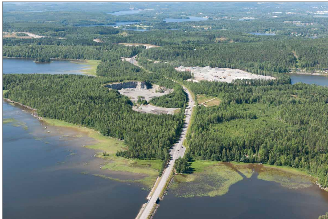
Kuva 35. Valtatie 9 idästä eli Leppäveden vesistön suunnasta Kanavuoreen päin kuvattuna. (Lentokuva Vallas Oy.)
