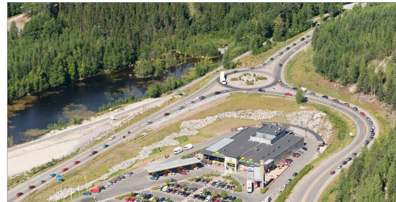
Kuva 17. Kanavuoren kiertoliittymä toimii ruuhka-aikoina huonosti ja kaikilla tulosuunnilla on pitkiä jonoja. Kuvan ottamisen jälkeen (v. 2010) Lahden suunnan haara on muuttunut (kuvan vasemmassa reunassa näkyy uutta tiepohjaa) ja kiertoliittymän länsipuolelle suunnalle Vaajakoski–Lahti on rakennettu oma kaista. (Lentokuva Vallas Oy.)
