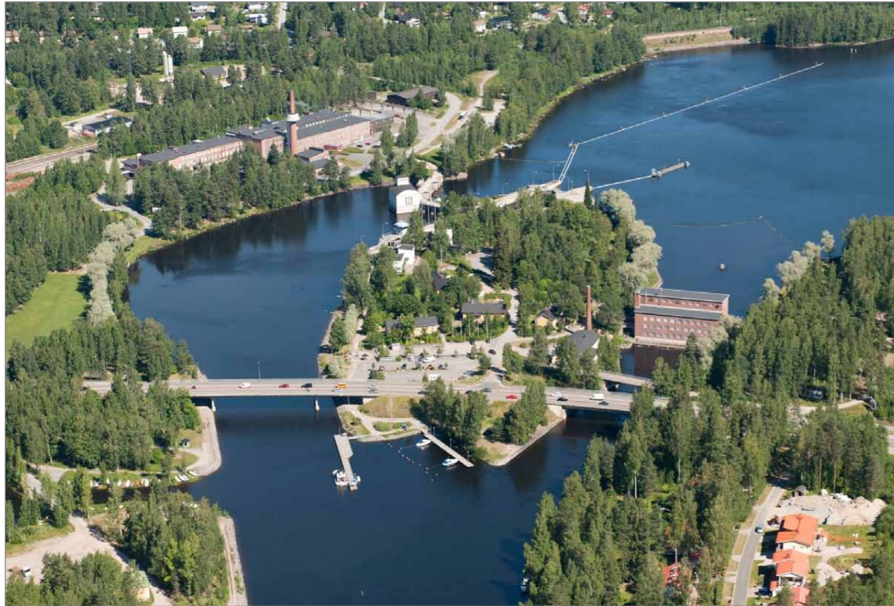
Kuva 22. Naissaari on merkittävä lähivirkistyskohde ja kulttuurihistoriallisesti arvokas miljöö. (Lentokuva Vallas Oy.)
