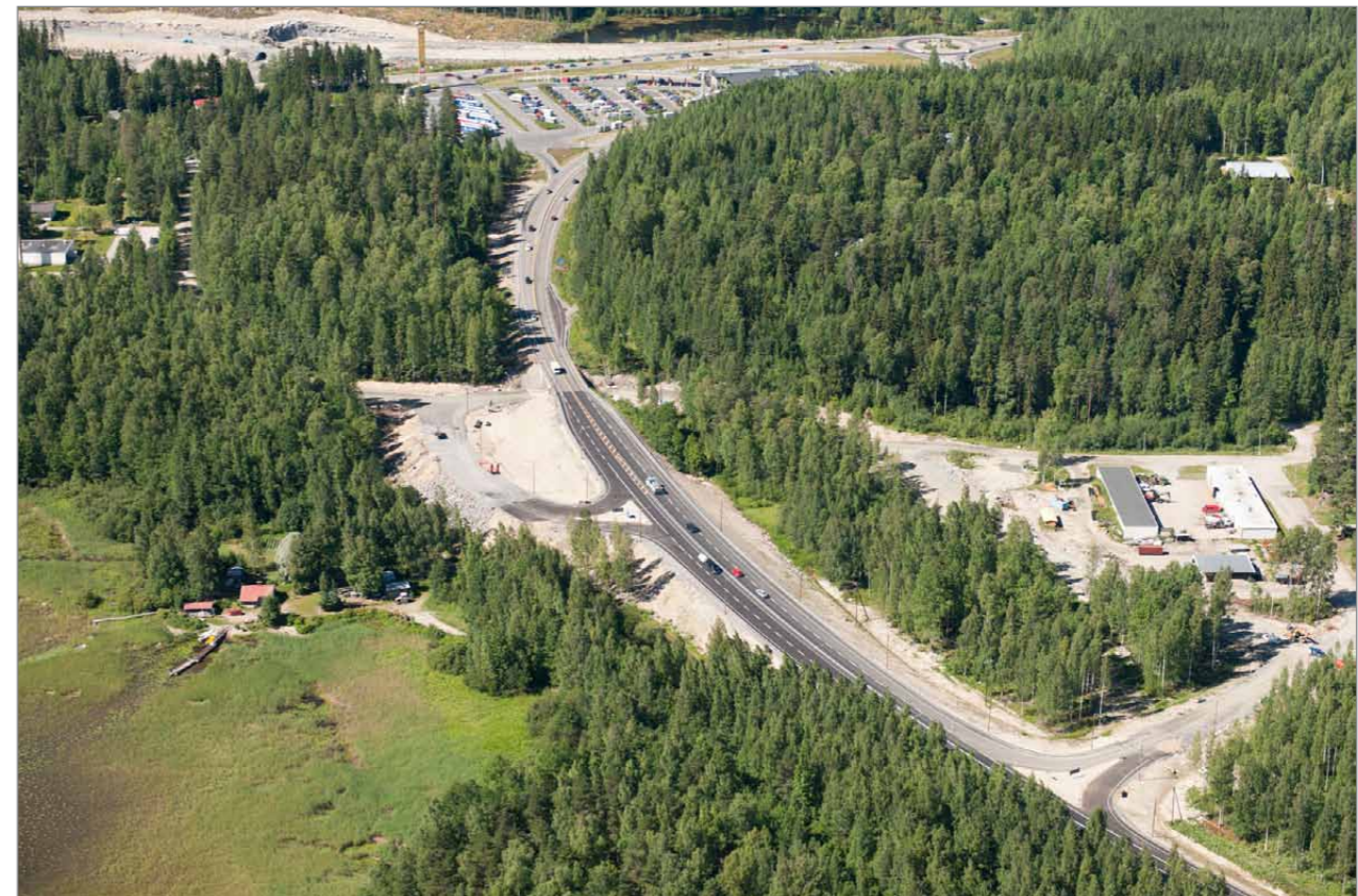
Kuva 36. Ruokosaaren eritasoliittymä valtatiellä 9 rakennusvaiheessa kesällä 2010. Tämä liittymä jää pois käytöstä Mustaniemen eritasoliittymän valmistuessa. (Lentokuva Vallas Oy.)
