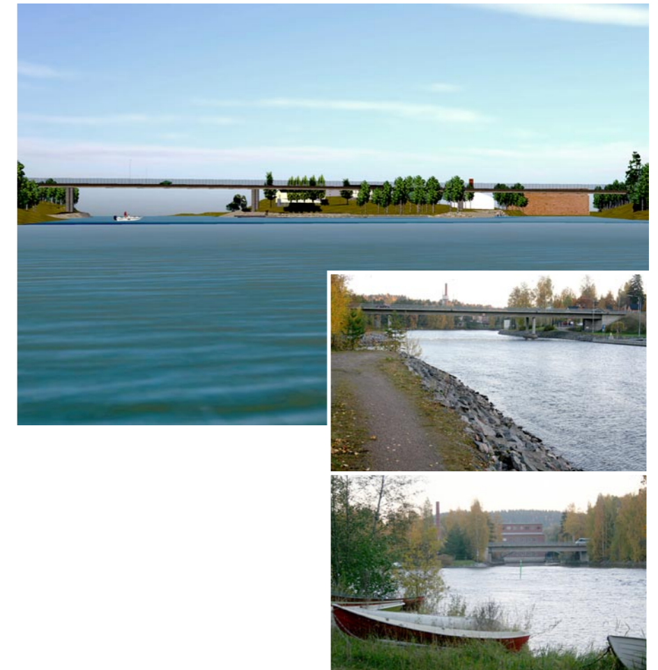
Kuva 38. Vaajanvirran ja Naissaaren sillan virtuaalimallinnus sekä valokuvat nykytilanteesta Naissaaren molemmiin puoliin syksyllä 2010. Kuvat vesialueen suunnasta lounaasta kohti siltoja.
