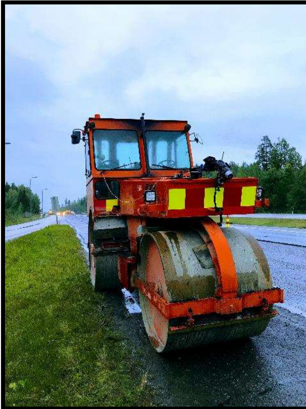
Kuva 2. Esijyränä oli perinteinen 3-valssinen staattinen jyrä. Punaisella ympyröitynä lämpökamera
