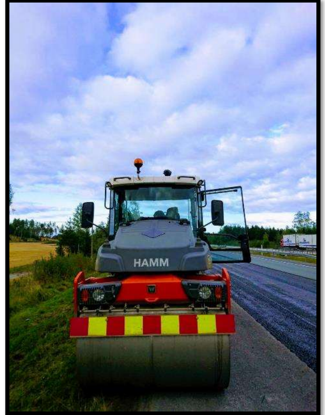
Kuva 3. Tiivistys- ja jälkijyränä oli uuden karheat täryjyrät
