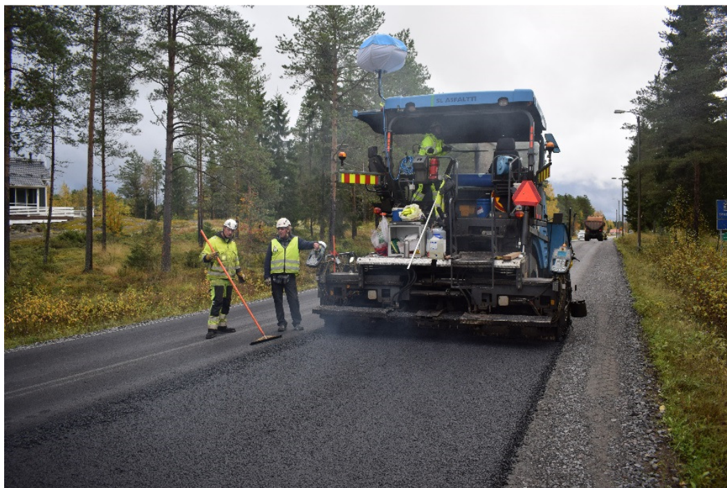
kuva 2. Asfaltin levitys
