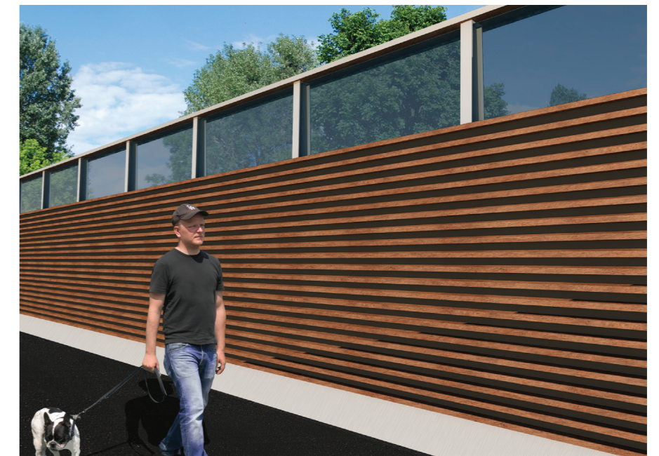
Kuva 12. Korkeaa melustetta voidaan keventää läpinäkyvällä yläosalla.
