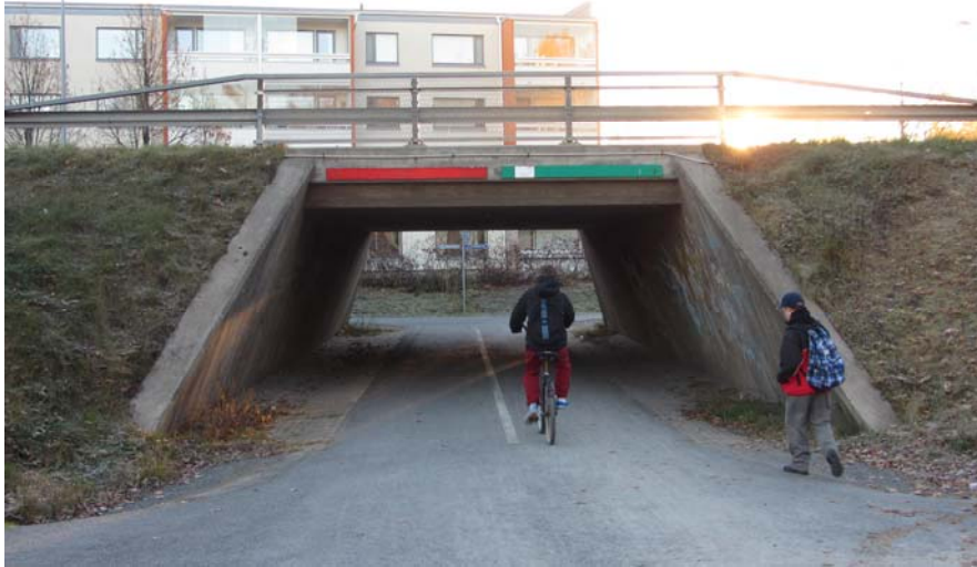
Kuva 128. Alikulku, jossa yhdistetyn pyörätien ja jalkakäytävän vastakkaiset kulkusuunnat on erotettu toisistaan värimerkinnoin.
