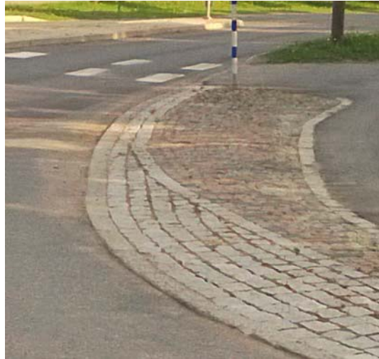
Kuva 107. Kiertoliittymästä poistuvien henkilöautojen ajonopeuden alentaminen on toteutettu poistumissuunnan yliajettavalla kiveyksellä (Ylöjärvi).
