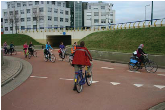
Kuva 124. Kahden pyörätien risteäminen Alankomaissa Houtenissa, jossa toisen pyörätien väistämisvelvollisuus osoitetaan katuun merkityllä väistämisviivalla (kuva: Kalle Vaismaa). Suomessa väistämisviivan käyttö edellyttää liikennemerkin käyttöä.
