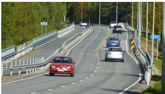
Kuva 31. Kaiteen käyttö sillan kohdalla (valtatie 20, Taivalkoski).
