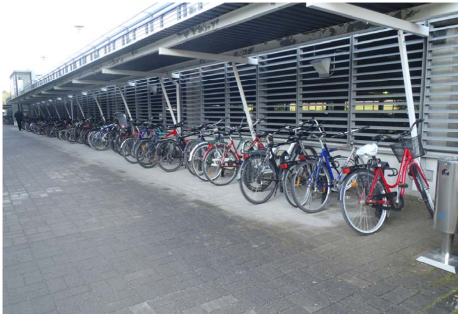
Kuva 183. Kokopäiväisessä pyöräpysäköinnissä pysäköinnin tulisi olla säältä suojattua ja turvallista (esimerkki Jyväskylän Mattilanniemestä).
