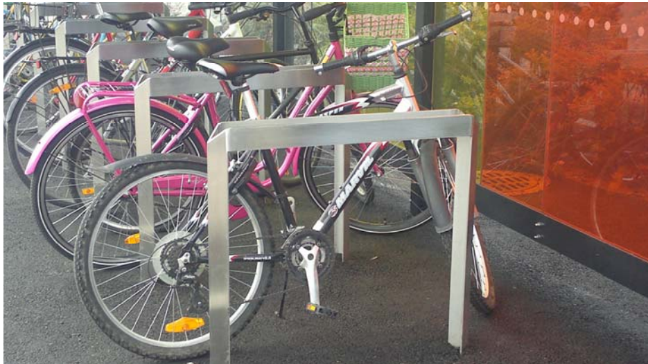
Kuva 187. Pyöräpysäköintiteline, johon pyörä tukeutuu rungollaan, esimerkki Helsingin Puotilasta (kuva: Mari Ahonen).
