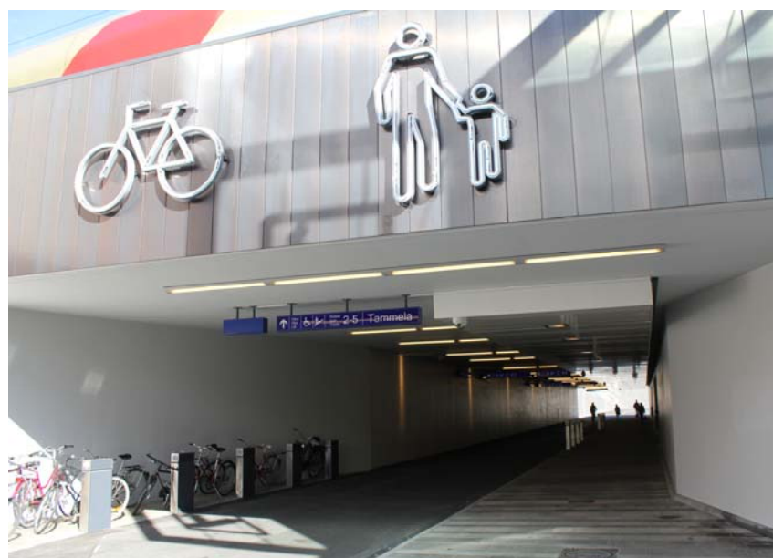
Kuva 127. Avara alikulku, jossa jalankulku ja pyöräily on eroteltu toisistaan rakenteellisesti.
