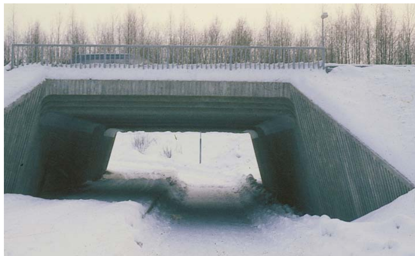
Kuva 131. Latupari ja jalankulku- ja pyöräilyväylä samassa alikulussa.
