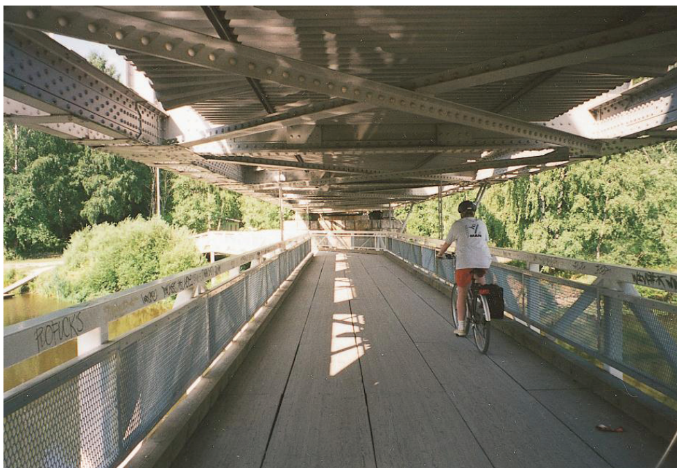
Kuva 133. Ripustettu jalankulku- ja pyöräilyväylän silta.
