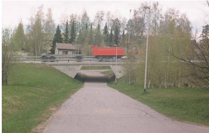
Kuva 130. Maastoon sovitettu ja avara alikulku. Loivat pituuskaltevuudet ja riittävät näkemät tekevät alikulun käytön miellyttäväksi.
